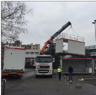
■ La zone de vie du chantier s'est installée ce mardi matin.
