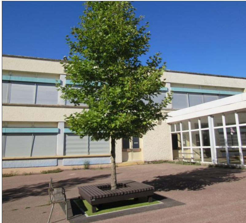
■ La Ville de Lyon va louer, pendant vingt-cinq ans, 50 m 2 de toiture à la société Un deux toits soleil. Photo d'archives Nadine MICHOLIN
